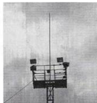
Рис. 10. Стержневой молниеотвод на отдельностоящей мачте
