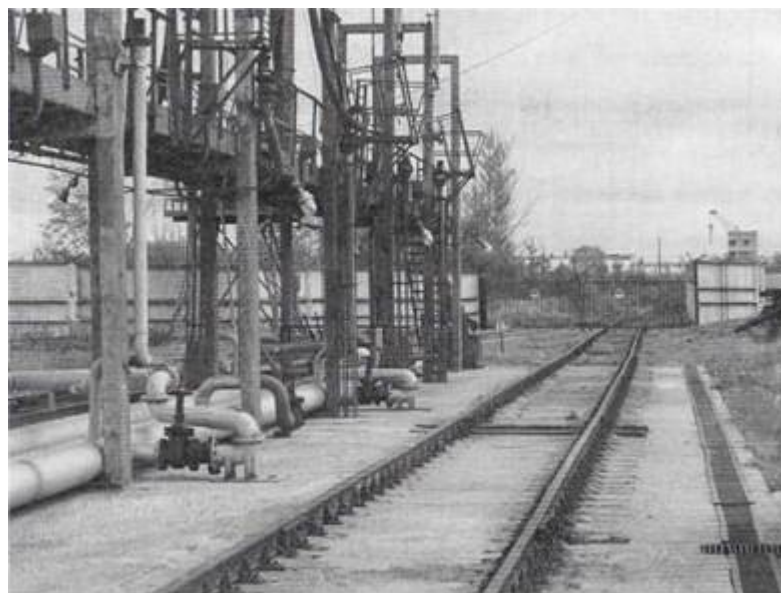
Рис. 3. Общий вид сливноналивной эстакады
